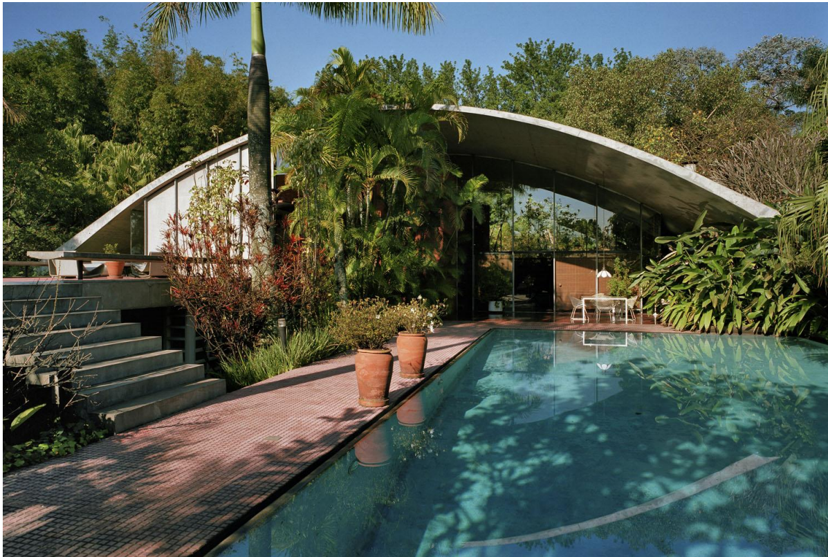
Figura 2: Cobertura em arco de concreto.
